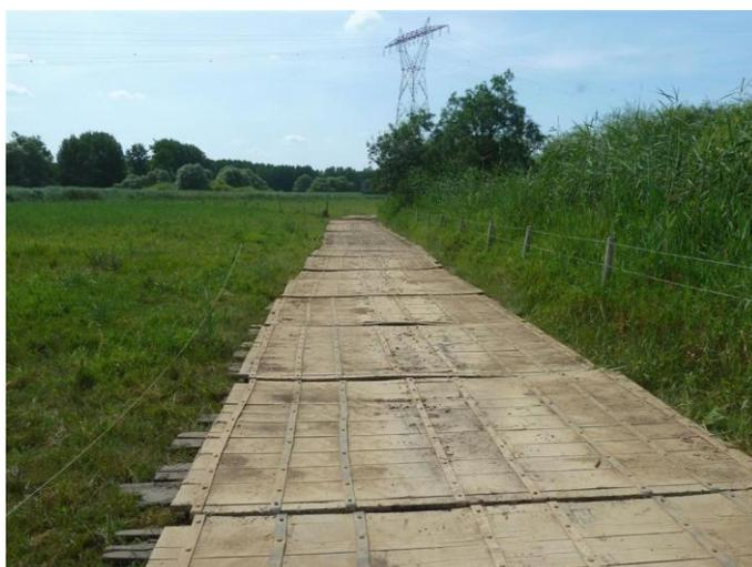
*Piste réalisée avec des plaques de répartition de charge*
