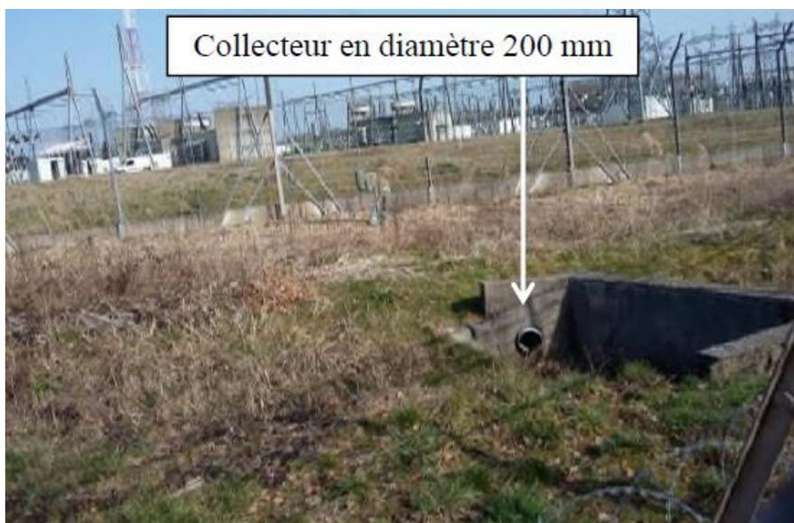
*Ouvrage bétonné recevant les eaux d'une partie du poste électrique et d'une zone de 15,5 ha situé à l'ouest du poste.*
