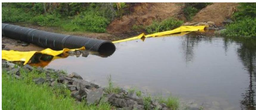
*Exemple de batardeau et de buse assurant la continuité de l'écoulement hydraulique*
