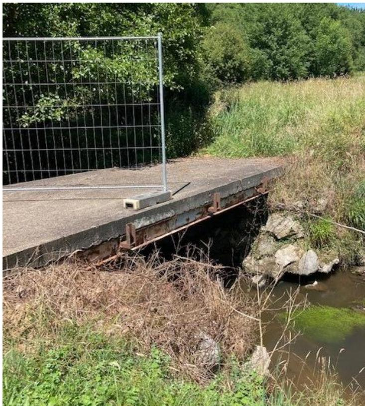
*Passerelle existante sur le ruisseau du Moulin de Lamothe à remplacer*
